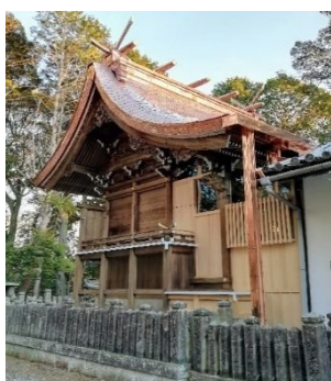
改修された八幡神社本殿
