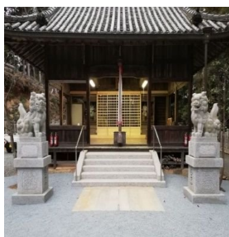
拝殿前石段改修及び手すり設置
