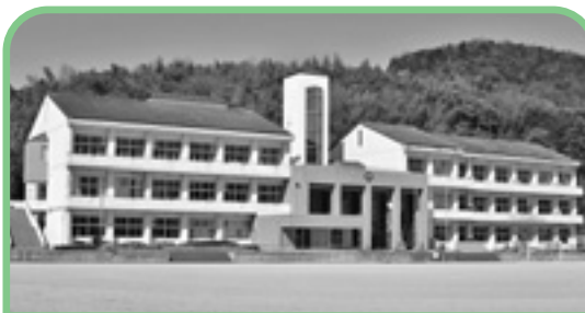
学校特別教室に空調とLED照明設置 4億2000万円
