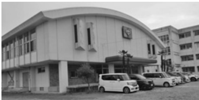
熱中症対策の空調設備が求められる体育館（福岡東中学校）
