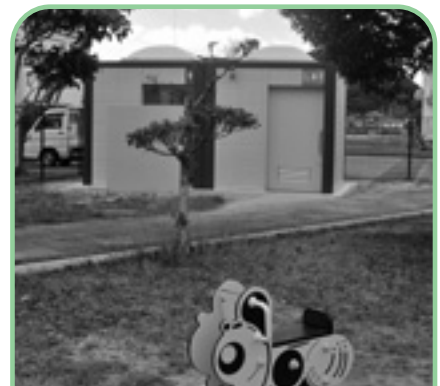
浄化センター修景施設 多目的トイレ等設置 2023万円
