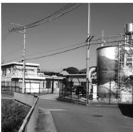
安心・安全な水を確保する福田水源地施設
