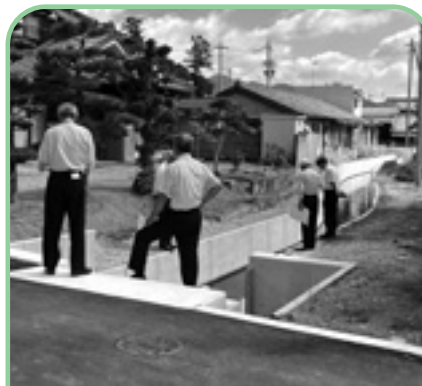
直谷第2雨水幹線工事 1億3400万円
