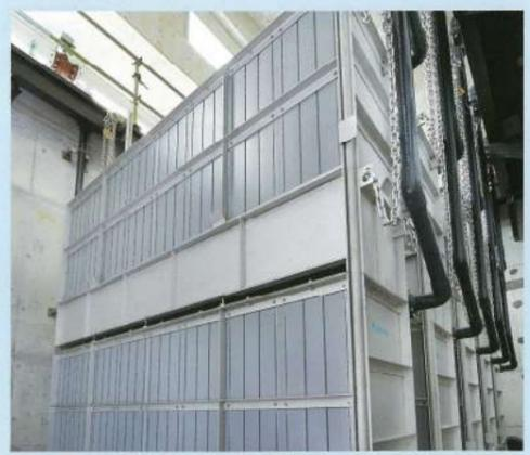
好気タンク内に設置された膜分離装置
