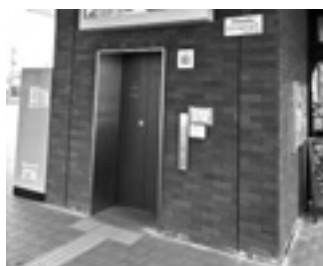
駅前観光交流センター外付けエレベーター
