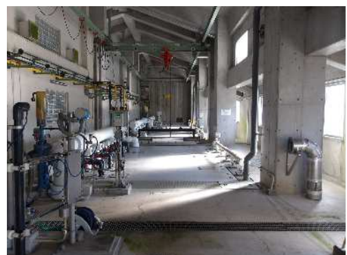
福崎浄化センター(水処理棟)
