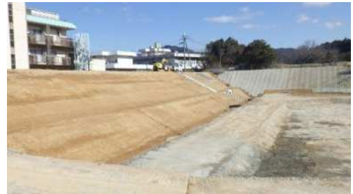
南大貫・宮の池 改修工事
