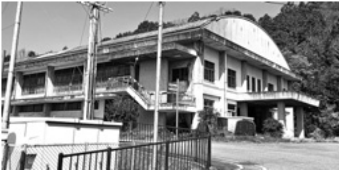
使用中止を予定している第2体育館
