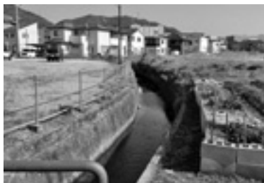
馬田区 工事箇所
