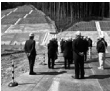
ごみ処理施設建設の進捗状況を確認
