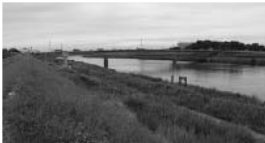
現在の栄橋 (昭和46年に架け替えられたもの)
