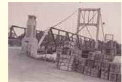
建設中の栄橋 個人蔵
