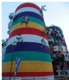
建設中の五色山と小袖山
