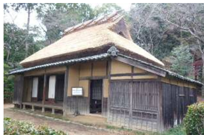
茅葺き屋根修理工事が完了した柳田國男生家
