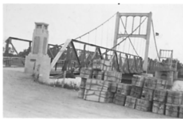
建設中の栄橋
